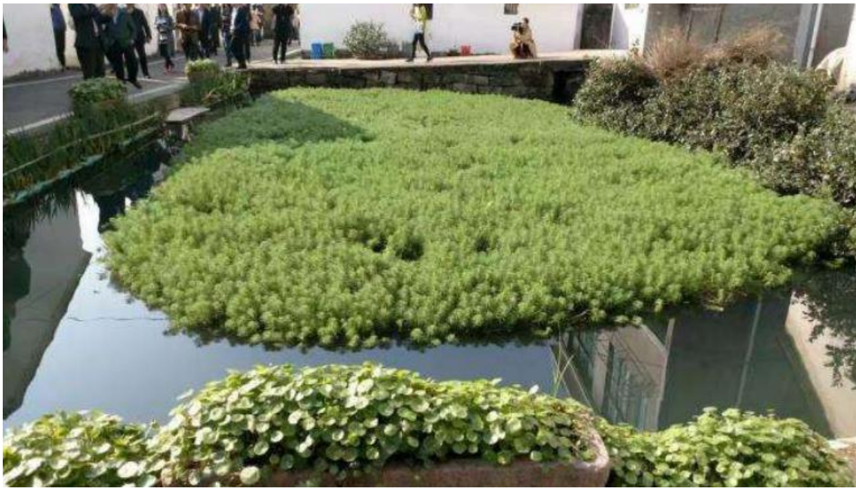
景观化处理污水净化池
