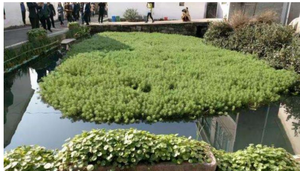
景观化处理污水净化池
