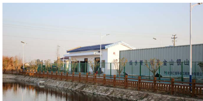
大通湖区乡镇污水处理厂提质改造工程
