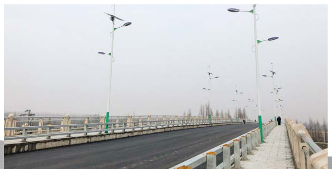
金盆二桥全线贯通
