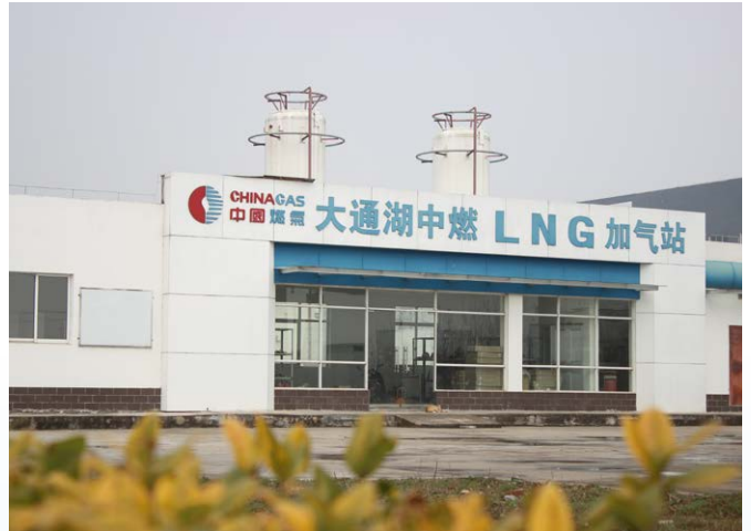
大通湖中燃 LNG 加气站
