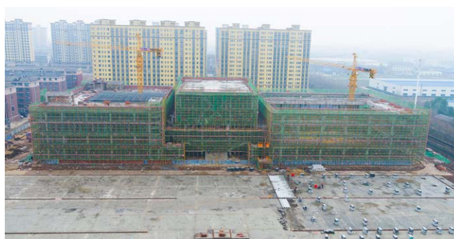
全民文体中心主体工程建设已封顶
