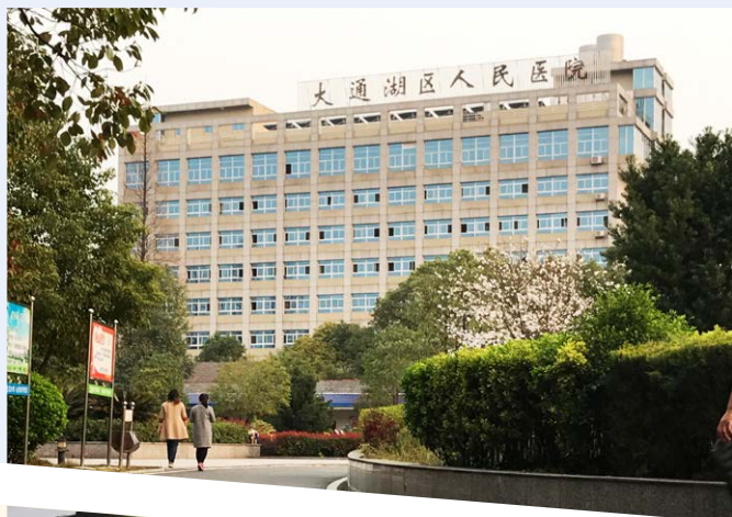
▽ 区人民医院成功创建二级甲等综合医院
